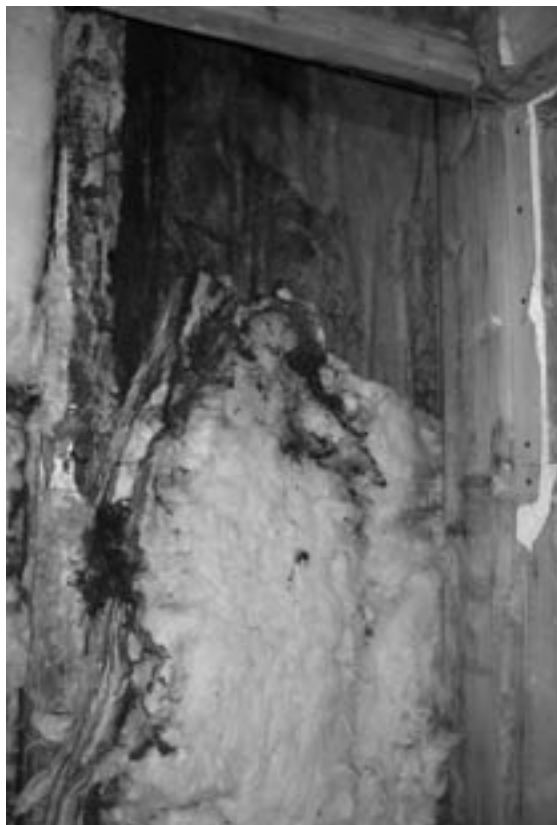
Ei täällä mitään kosteusvaurioita ole...
